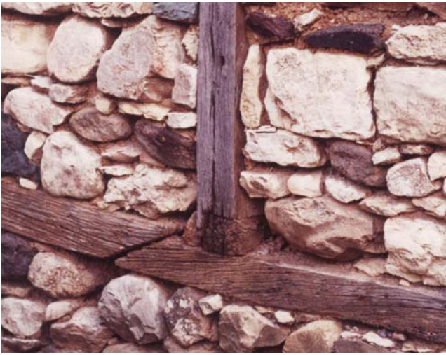
Şekil 12. Bölgedeki bazı geleneksel yapılarda tabanlara ek yapılması, Yalova
