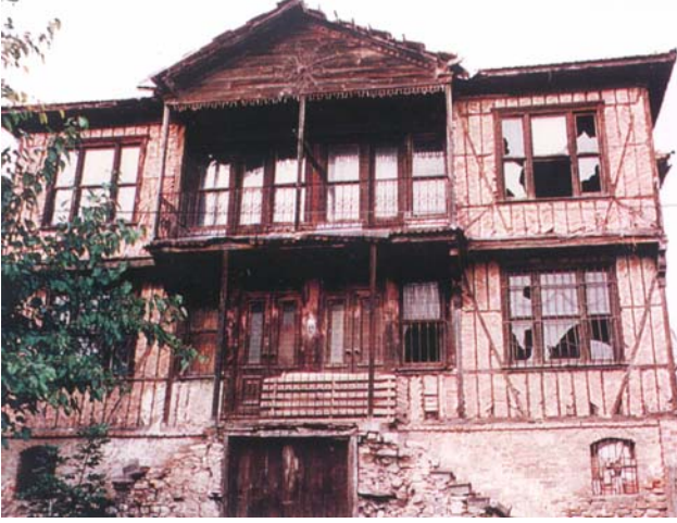
Şekil 6. Zemin katı kargir üst katı ahşap iskeletli yapı örneği, Gebze Tavşancıl
