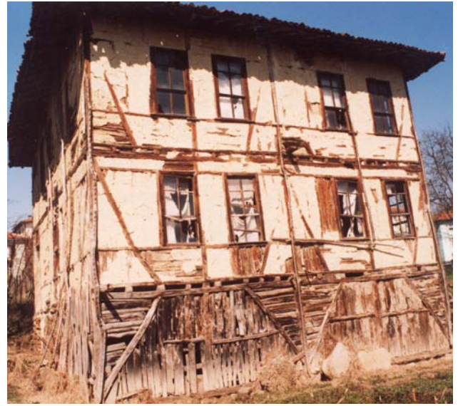
Şekil 8. Zemin katı hımış, üst katı bağdadi yapı örneği, Gölcük Saraylı
