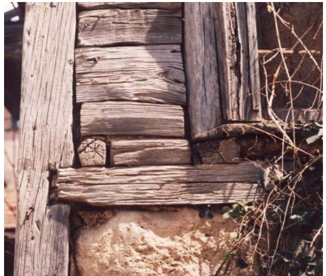
Şekil 17. İki kat boyunca devam eden dikmeye yatay bölme elemanının saplanması, Yukarı Değirmendere
